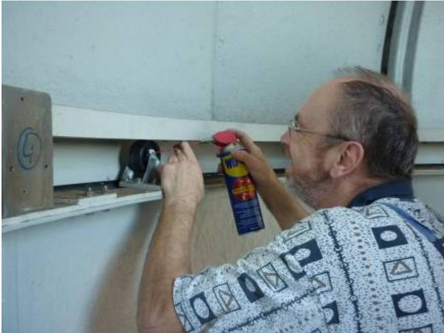
Zu unserem Erstaunen waren das simple Laufrollen, wie man sie unter jedem einfachen Rollwagen findet, die Achse nicht mal kugelgelagert, zur Fixierung nach Innen zum Kuppelraum leicht geneigt. Um die Kuppel in der Spur zu halten, waren weitere 6 Vertikalrollen gleicher Bauart montiert, auch die wurden mit Schmiermittel behandelt.
